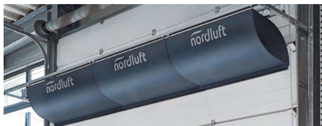
Horizontale Installation von drei TLS 1,5
