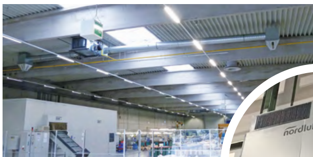
Logistikzentrum für Flugzeugteile: decken- hängende Anlage mit 4-seitigen Ausblasköpfen.
