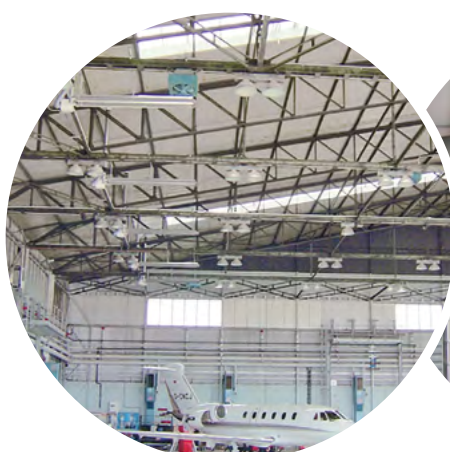
Beheizung eines Flugzeug-Hangars
