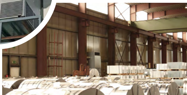
Metall-Coillager: Permanent-Beheizung zur Verhinderung von Rostbildung.
