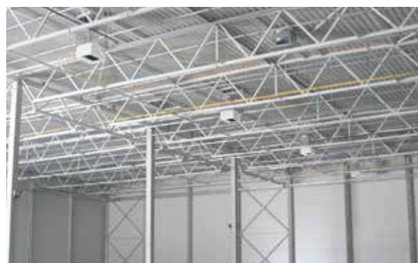
Deckenmontage von GasaTherm F-Geräten. Systemvorteil: Wärmrückführung aus dem Deckenbereich durch die Geräte selbst.
